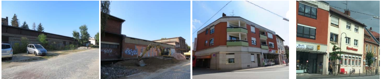
Hoher Sanierungsbedarf durch Gestaltungsmängel an den Gebäuden in der Ladestraße und Binger Straße / Mainzer Straße
