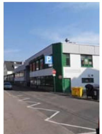
Abb.45: Leerstehende Karls-Passage auf dem Grundstück Nr. 6 (Quelle: planquadrat)
